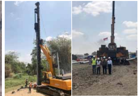
Gambar 28. Pembangunan Pondasi di Sisi Sungai Winong (Kiri) dan Peninjauan Pembangunan Kampus ITB Cirebon oleh Tim dari ITB (Kanan).
