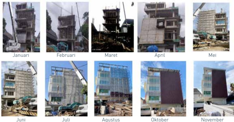
Gambar 20. Kemajuan pembangunan Gedung Science and Techno Park.
