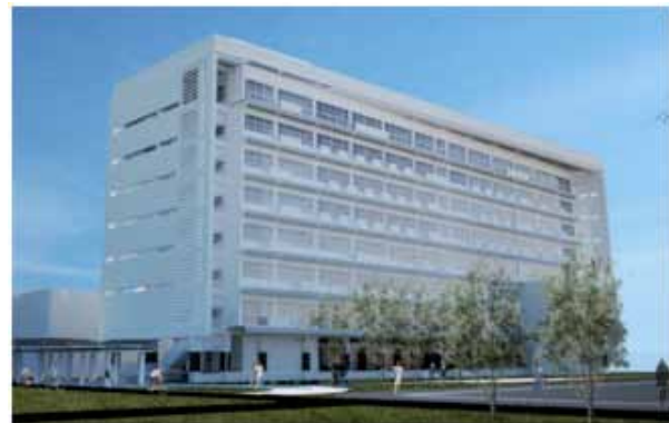
Gambar 21. Pembangunan Gedung LabTek XV (Prodi Kimia).
