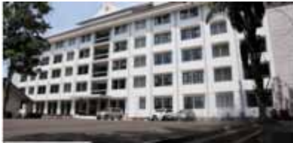
Gambar 24. Pembangunan Gedung Rusun Dosen ITB Jatinangor
