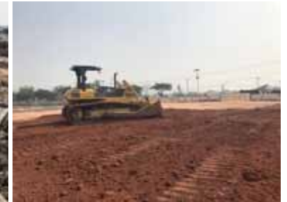
Gambar 29. Pembangunan Pondasi Salah Satu Bangunan (Kiri) dan Perataan Tanah untuk Bangunan Baru (Kanan).
