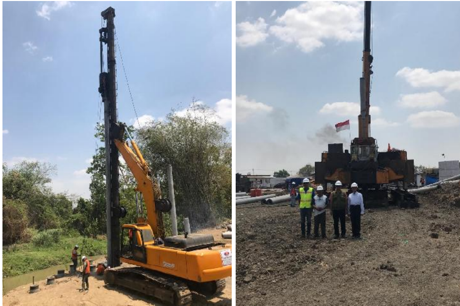
Gambar 3.27. Pembangunan Pondasi di Sisi Sungai Winong (Kiri) dan Peninjauan Pembangunan Kampus ITB Cirebon oleh Tim dari ITB (Kanan)
