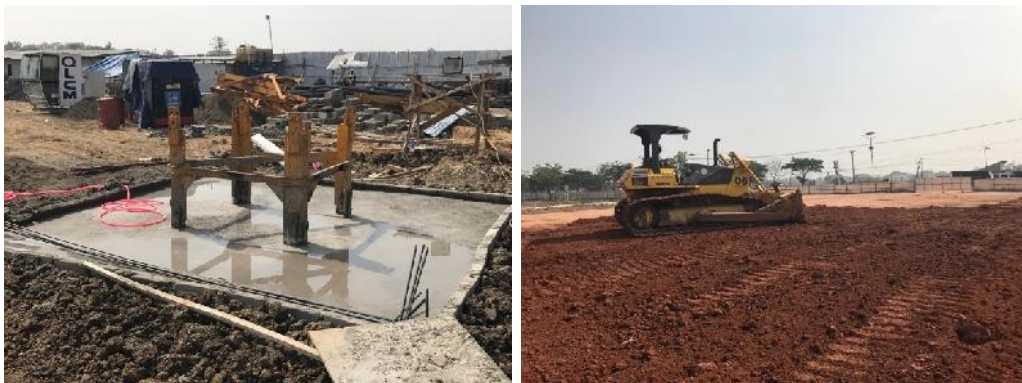
Gambar 3.26. Pembangunan Pondasi Salah Satu Bangunan (Kiri) dan Perataan Tanah untuk Bangunan Baru (Kanan)
