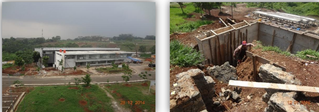
Gambar 2. Konstruksi Laboratorium Sedimentasi Tahap II
