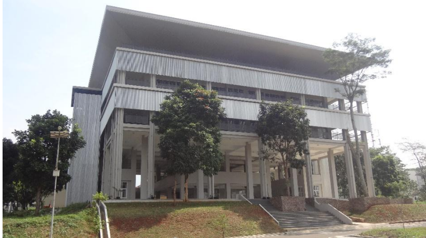
Gambar 3. Konstruksi GKU 1 ITB Jatinangor
